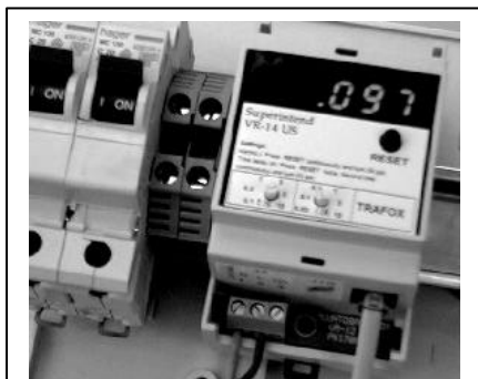
Bild 2.1.1 VR-14 utrustningen kan monteras på DIN 35 skena.
