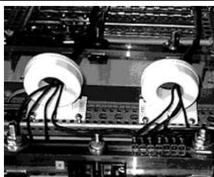
Bild 2.1.4 Montering av summaströmstransformatorer
