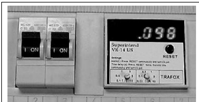
Bild 2.1.2 VR14 passar in i DIN-slits i elcentral.
